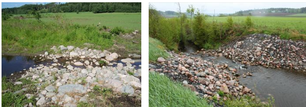
Kuva 5. Esimerkkejä rakennetuista pohjapadoista. (ymparisto.fi)
