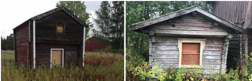
Kuva: 45 Vasemmalla otsallinen pikkuaitta Niemikyläntieltä. Oikealla Joensuuun pihapiiriin pikkuaitta 1700-luvulta.
