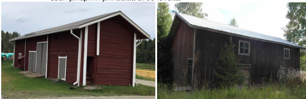
Kuva: 46 Lamminmäen tilan ja Housunmäentillä sijaitsevaan luhtiaittaan on käynti päädyistä.
