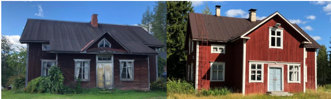
Kuva: 44 Selvitysalueella on myös harvinaista sodan aikaista rakennuskantaa: vasemmalla Hirvelän päärakennus vuodelta 1941, oikealla Järvisalon päärakennus vuodelta 1942.
