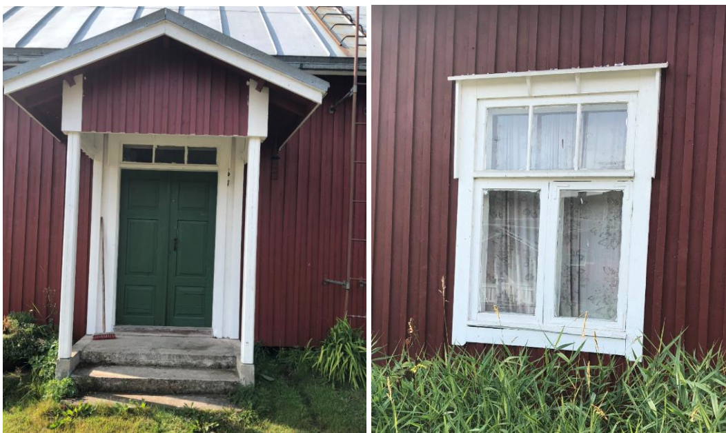
Kuva: 43 Iso-Ahon päärakennuksen yksityiskohtia: ovi yläikkunoihin, avo-kuisti ja T-mallinen ikkuna, jonka yläruutu on jaettu kolmeen pienempään ruutuun.
