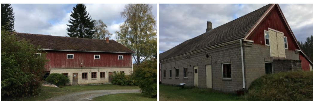
Kuva: 52 Vasemmalla Mäki-Mutkan navetassa on yhdistetty sementtitiiliä ja puuverhous. Oikealla Pesolan näyttävä navetta.
