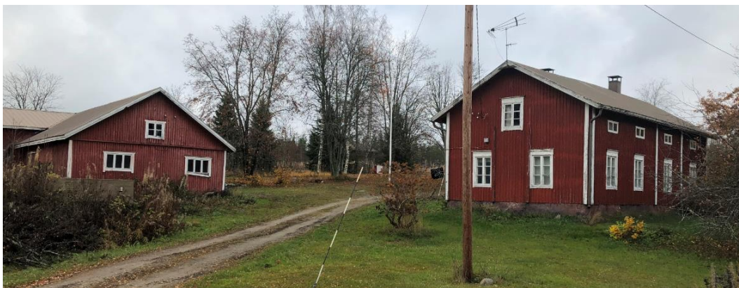
Kuva: 38 Akkalan pihapiirissä on selvitysalueen vanhinta rakennuskantaa.
