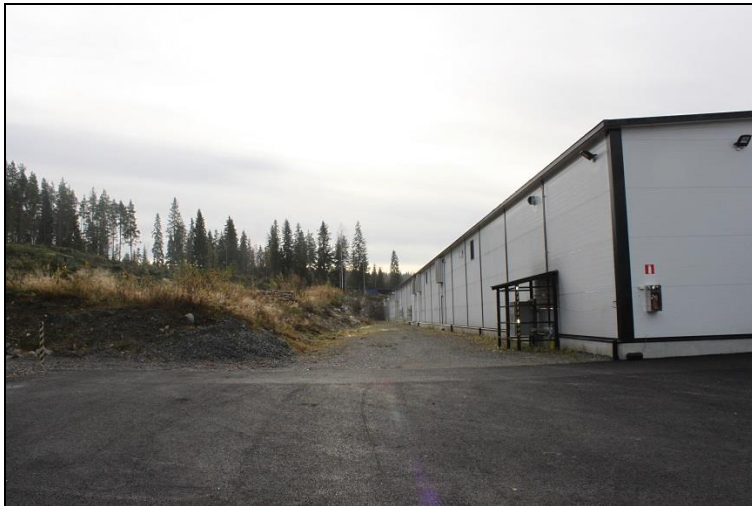
Kuva 4: Leipomorakennus tulevan laajennuksen puolelta.
