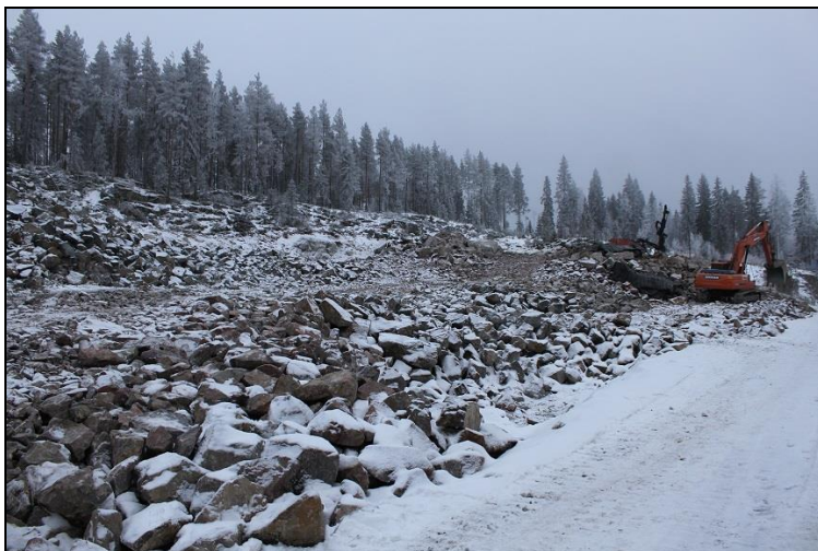
Kuva 5: Louhintatyömaa kuvan 4 mukaisella alueella
