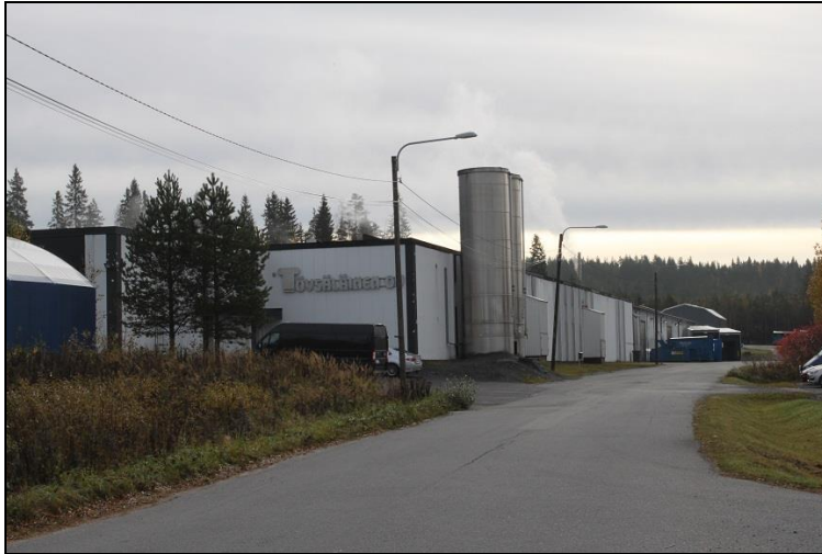
Kuva 3: Kiinteistöllä 10-409-24-384 Herkkukorppu oleva leipomorakennus.
