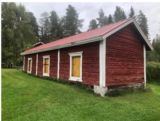
Kuva: 43 Pänkälän Kirmaalta siirretty aitta on kolmen huoneen levyinen hirsiaitta vuodelta 1896. Oikealla Kirmaan päätyovelliset aitat.
