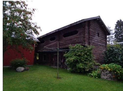
Kuva: 42 Ylitalon tilan vuonna 1775 rakennettuun luhtiaittaan on käynti päädystä, kun taas Mäki-Haanpään luhtiin käydään keskeltä luhtia.
