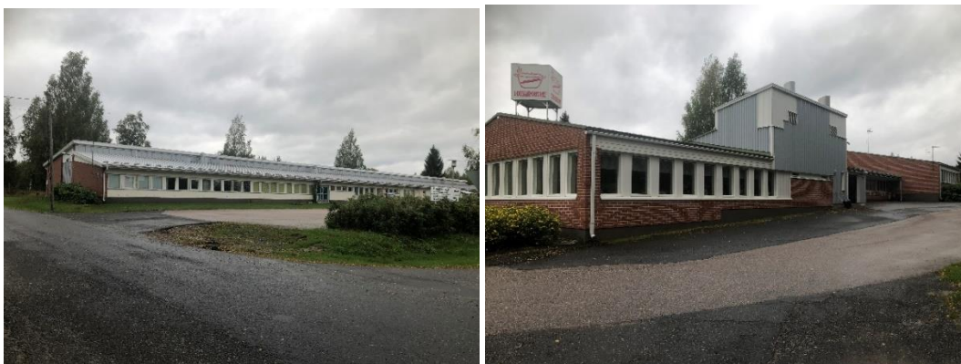
Kuva: 46 Vasemmalla Elinkeinotalo ja oikealla Okslammintie 9:n julkinen rakennus.
