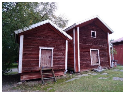
Kuva: 43 Pänkälän Kirmaalta siirretty aitta on kolmen huoneen levyinen hirsiaitta vuodelta 1896. Oikealla Kirmaan päätyovelliset aitat.
