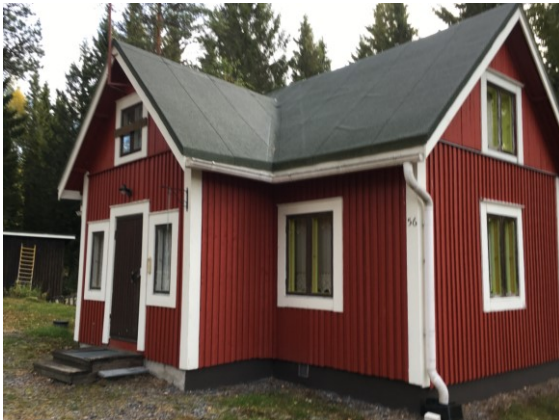
Kuvissa: 9 Päärakennus taustalla talousrakennus.
