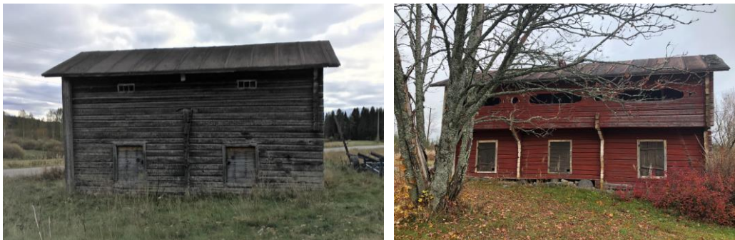
Kuva: 51 Kosolan luhtiaitta vasemmalla ja Akkalan luhtiaitta oikealla.
