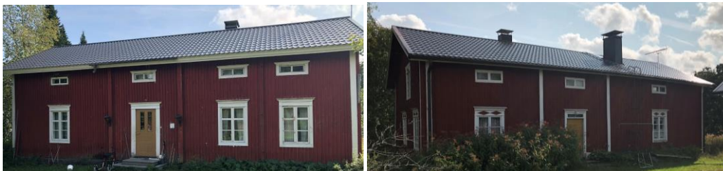
Kuva: 44 Vasemmalla Mäkitalon ja oikealla Ranta-Akkalan päärakennus vuodelta 1920. Molempiin käydään sisään suoraan eteiseen, eikä rakennuk- sessa ole kuistia.
