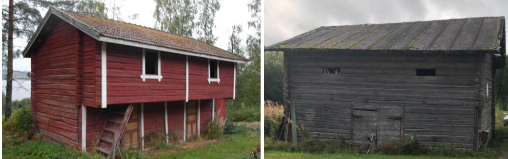
Kuva: 50 Rankilan luhtiaitta on kahden huoneen levyinen ulokkeellinen hirsiaitta. Solaan on kulku tikapuita myöten. Oikealla Akonniemen luhtiaitta on harmaantunut hirsipinnalla oleva kaksitasoinen rakennus. Rakennuksessa on pitkät nurkat. Kulku julkisivultaan suljettuun solaan on rakennuksen päädyistä.
