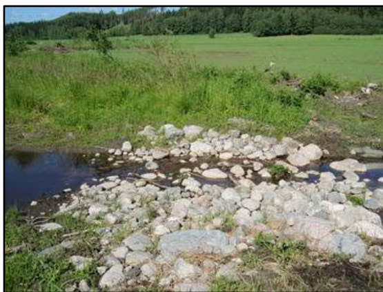
Kuva 5. Esimerkkejä rakennetuista pohjapadoista. (ymparisto.fi)
