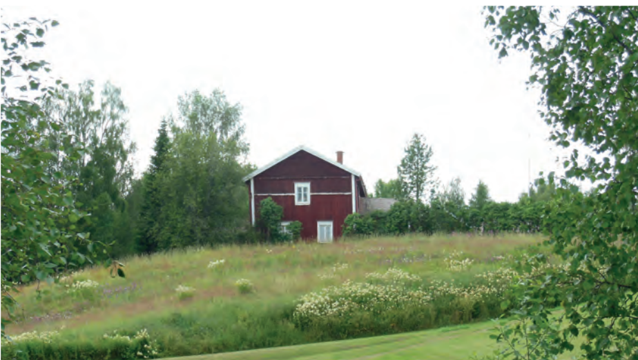
^ Saaren talo Möykyssä on alueen vanhinta rakennuskantaa. (RA) Jokitöyräillä on säilynyt vanhaa rakennuskantaa. (RA) Möykyn jokitöyräasutusta. (RA)
