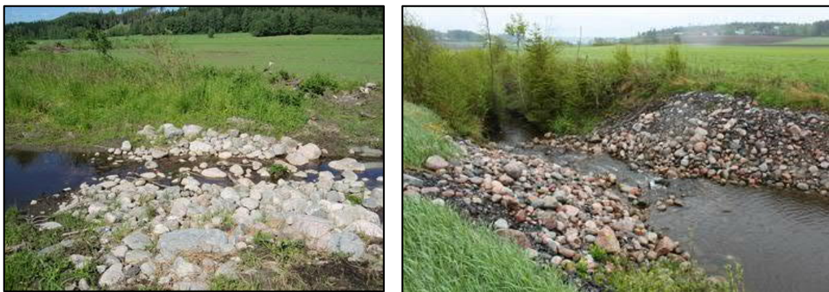
Kuva 5. Esimerkkejä rakennetuista pohjapadoista. (ymparisto.fi)
